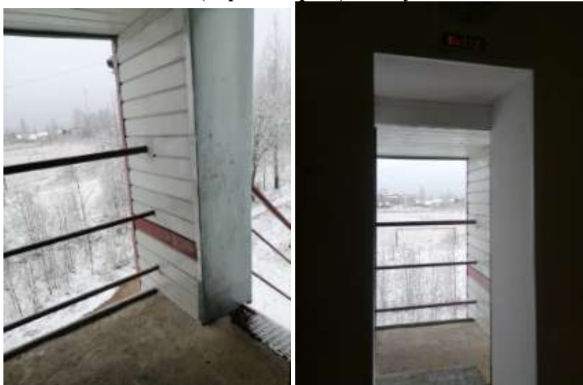
Входная площадка (перед дверью) Эвакуационный выход №1 второй этаж
