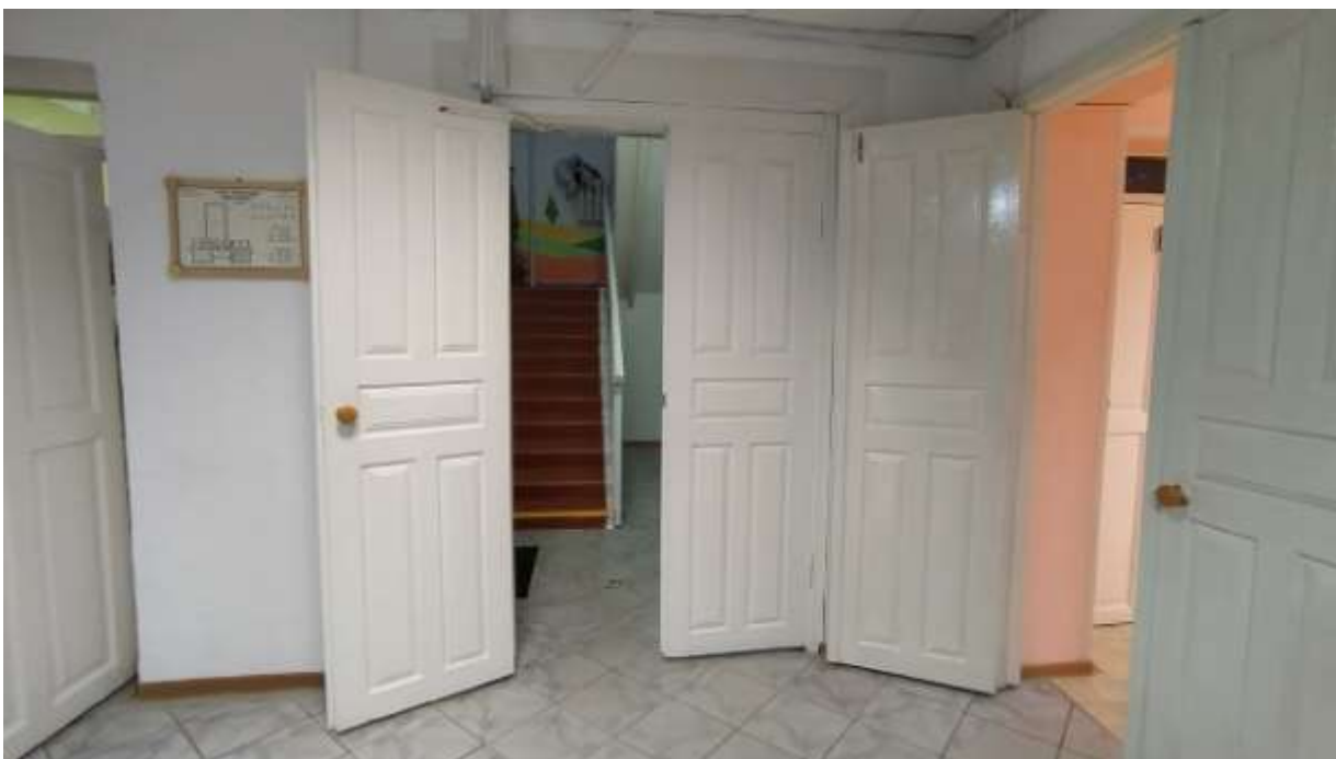
Двери внутри здания
